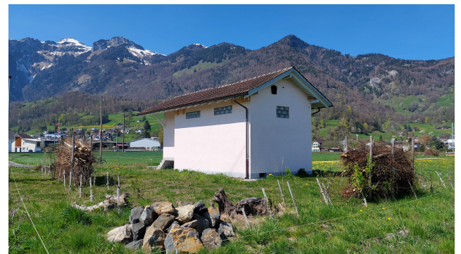
Die Trafostation in Rüthi zeigt auf, wie Infrastrukturflächen ökologisch aufgewertet werden können.
