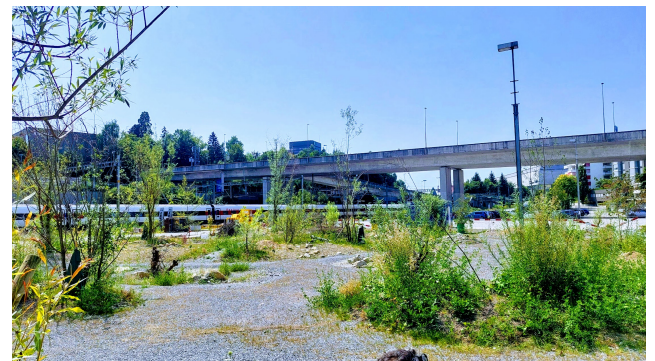
Die über 2'500 m 2 erweiterte Fläche auf dem Areal Bach nach dem Umbau im 2025.
